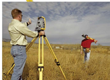
کنترل اتوماتیک مسیرها، کارتان را همانطور که راه می‌روید کنترل می‌کند.
